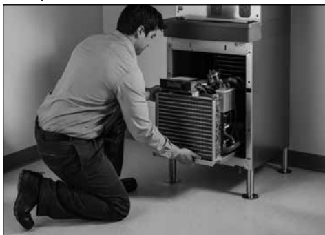
Máquina de hielo desmontable para facilitar las operaciones de servicio
